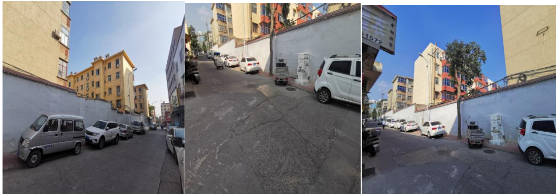
11、曹记修车对面及南北两侧 摆放广告牌，路面破损、坑洼，占道经营，杂物堆放。
