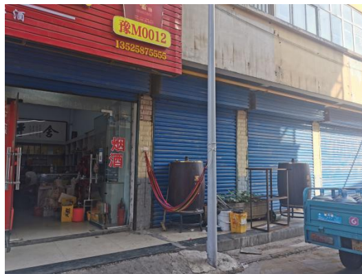
8、长生街与珠江路交叉口 占道经营、路面破损。
